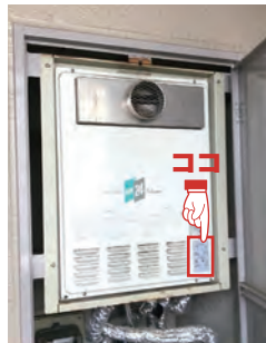
給湯器の型式確認(例) 給湯のリモコン（操作パネル）に記載されているものはリモコンの型式です。本体を確認しましょう。
